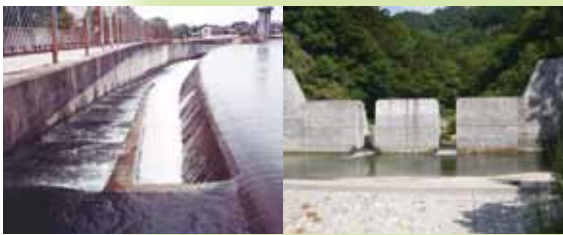
水の流れる魚道の設置や堰堤のスリット化
