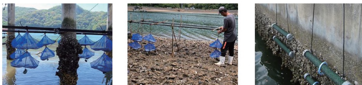
図 5-4. ケアシェル採苗器の設置の様子。 作業用棧橋の橋脚を利用した設置（左）、仮設の棚を利用した設置（中央）、岸壁への設置（右）。
