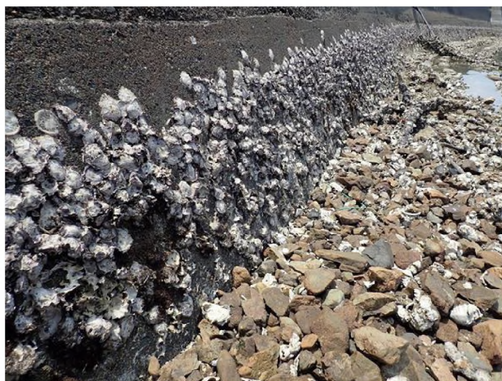
図 3-3. 潮間帯のコンクリートの護岸に付着した天然のマガキ。
