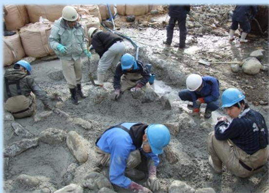
河川堰堤における魚道改修のようす
