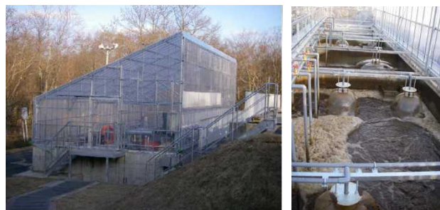
排水処理施設（北海道区水産研究所鶴居さけます事業所）
