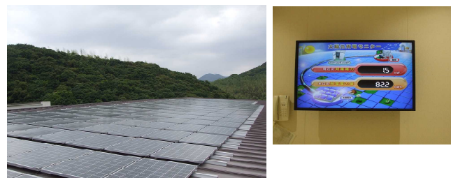
水産大学校多目的学生教育棟に設置された太陽光発電パネル（左）及び発電状況を表示するパネル（右）
