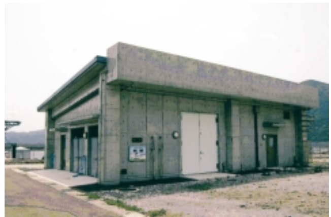
写真1 排水処理施設
