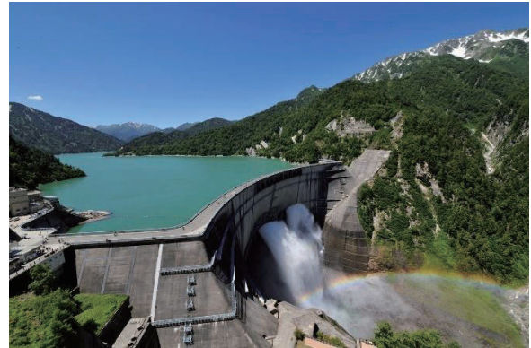
図3. 日本一の堰高186mを誇る黒部ダム 1963年6月、関西電力によって完成。(資料提供: 関西電力株式会社)
