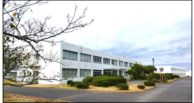
神栖庁舎 研究本館（左手前）と研究管理棟（右奥）
